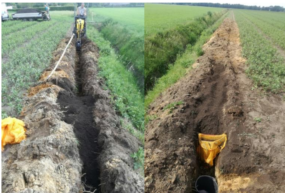
Figuur 4.5: Aanleg greppels bij teler 2.
