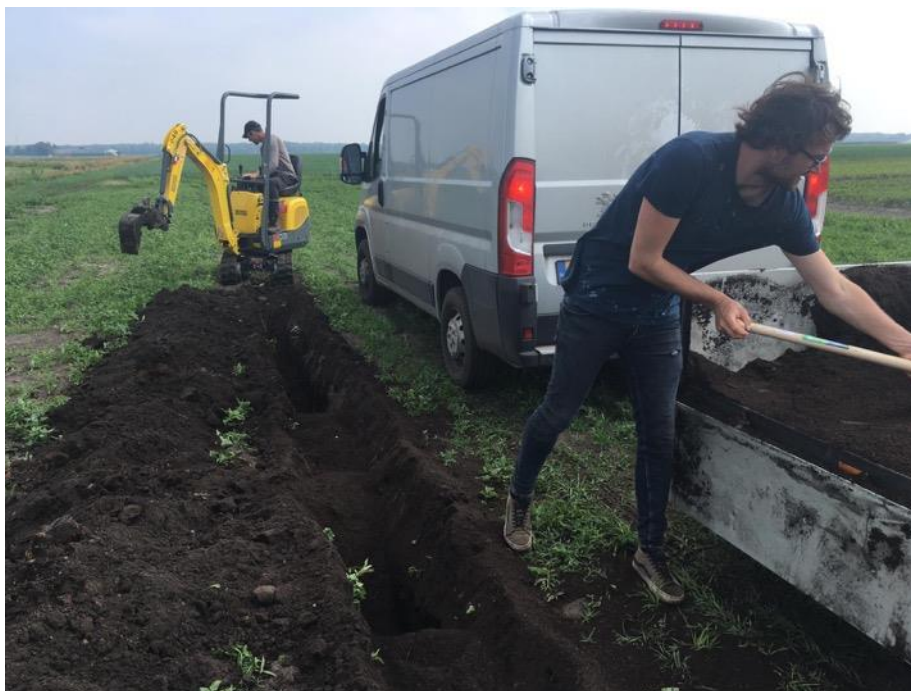
Figuur 4.2: Aanleg infiltratiegreppel m.b.t. van kraan. De compost werd vanaf de kar in de greppel geschept.
