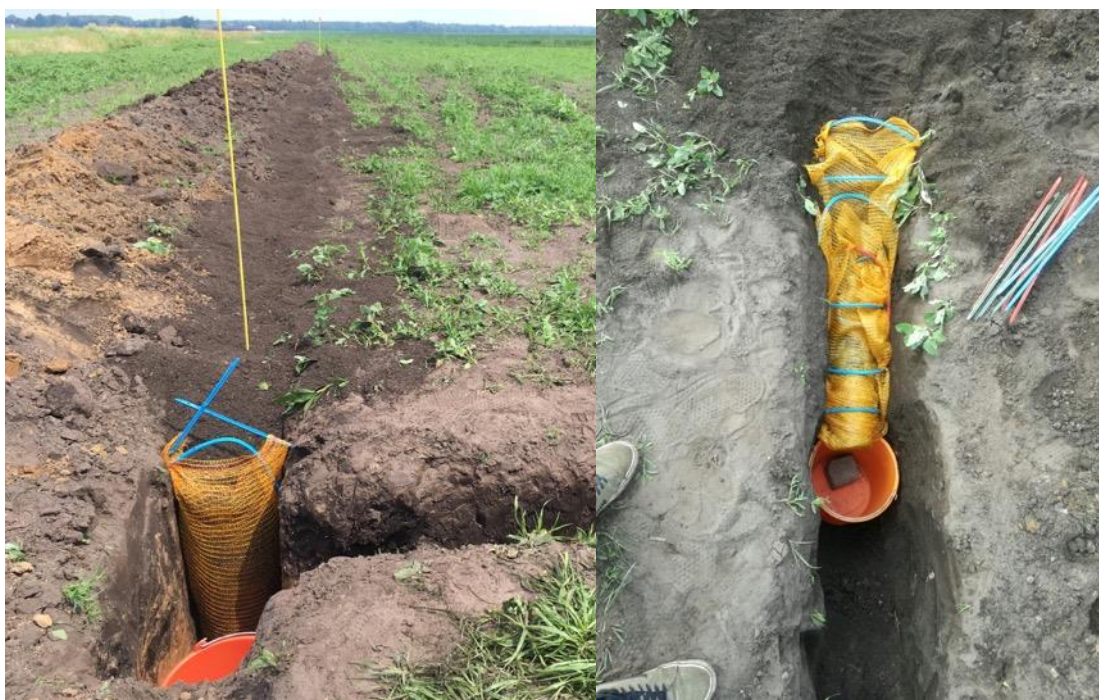
Figuur 4.3: Plaatsing emmers en netten om te voorkomen dat de compost in de emmer loopt. Op de rechter afbeelding is de buis die vanuit de compost in de emmer loopt te zien (M2).
